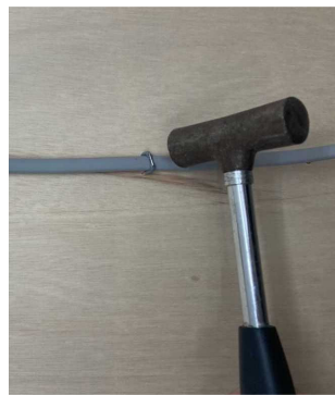
【壁などへの電線の取り付け】
