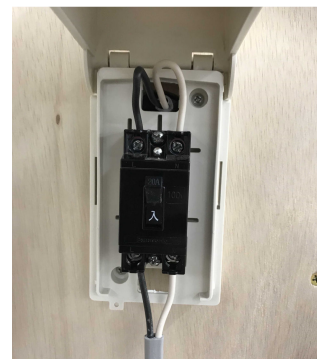
【ブレーカーと電線の接続】
